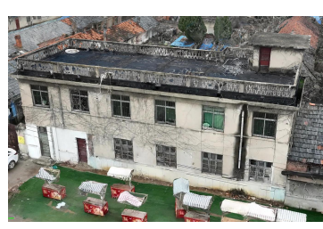
铁路建筑段办公楼
