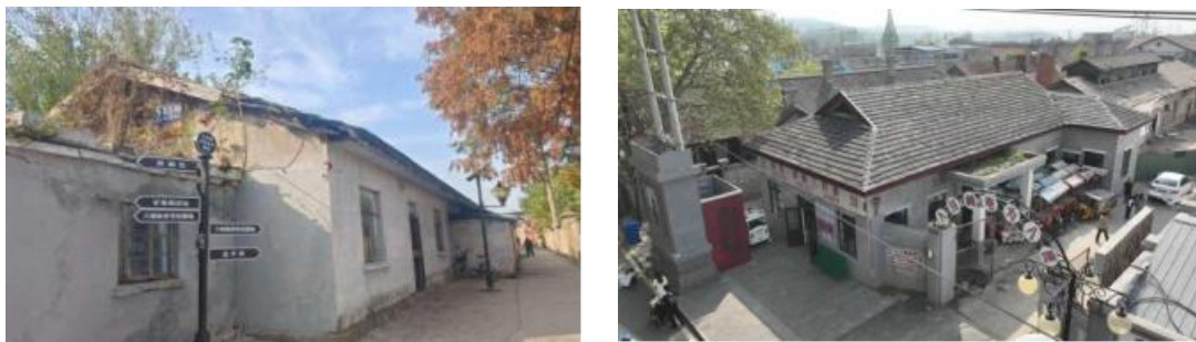
图 57 街区内历史建筑现状
