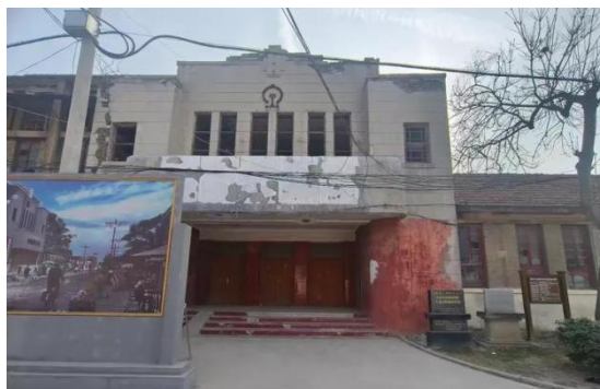
图 27 九龙岗民国建筑群 (九龙岗铁路俱乐部建筑群)
