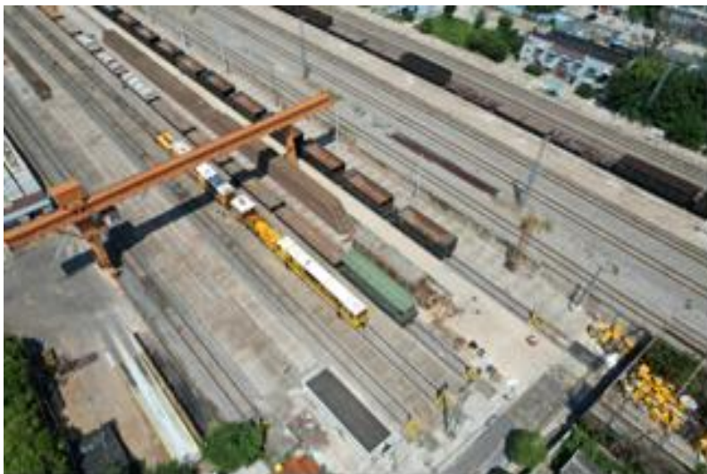
图 38 淮南铁路（九龙岗段）现状照片
