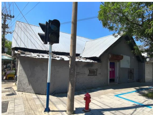
图 48 街区市政基础设施提升
