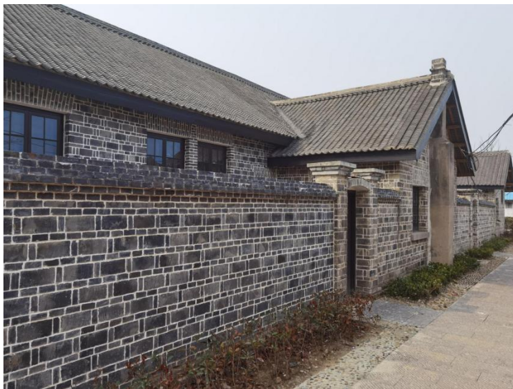
图 25 九龙岗民国建筑群（九龙岗“天地玄黄宇宙”民国建筑群）
