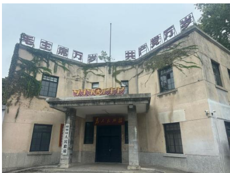
图 26 九龙岗民国建筑群 (淮南矿业所办公楼)
