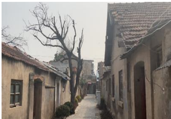
图10 修缮前的民国建筑群
