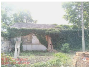
淮南铁路九龙岗站货运办公室旧址
