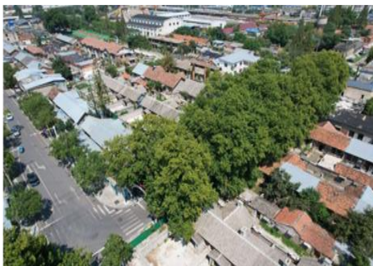
图 37 梧桐树现状照片
