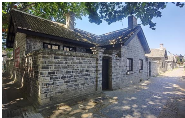
图11 修缮后的民国建筑群
