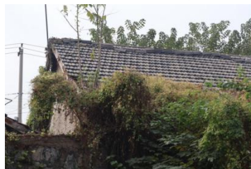
淮南铁路九龙岗火车站老乘务所
