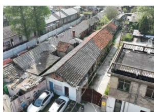
铁路建筑段办公室
